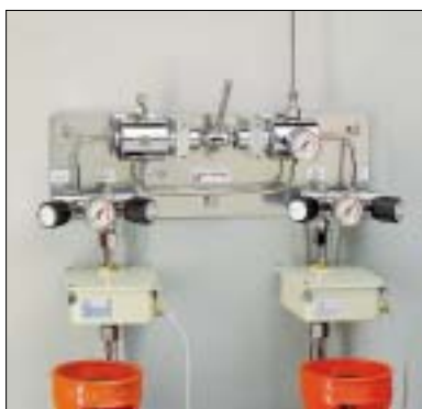
LRX ① ** förvärmare monterade på en CLSA tömningscentral
